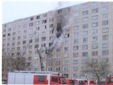
1. kép: A Debrecen, Fényes udvar 6. sz. alatti épület déli homlokzatának összképe tűzoltás közben
