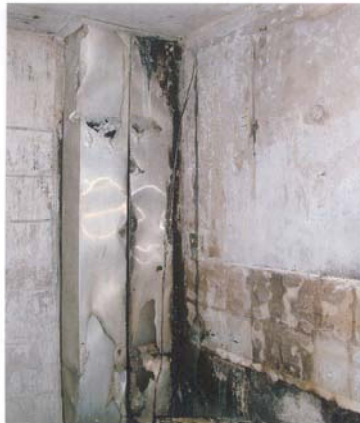
3. kép: A Debrecen, Fényes udvar 6. sz. alatti épület X. emeleti konyhájának belső képe a tüzeset után, háttérben a szagelszívó vezetékek maradványaival
