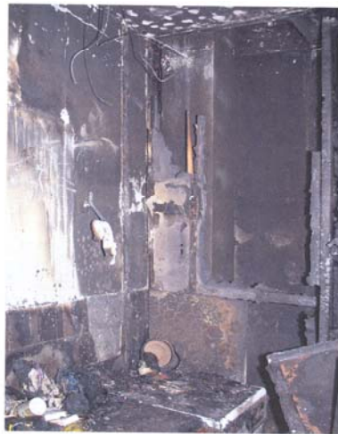
7. kép: A VIII. emeleti lakás konyhájának belső képe. Itt jól megfigyelhető, hogy a tűzhely eredeti helyén található és az akna – nagyrészt megsemmisült – fuvázás farostlemezburkolata is még eredeti
