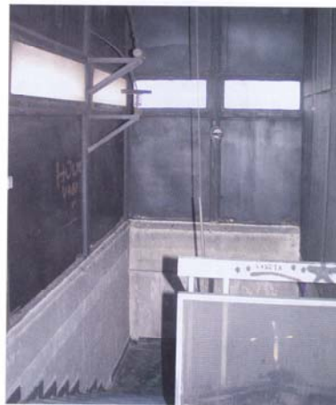
9. kép: A lépcsőház legfelső szintje, balra a gravitációs hő- és füstelvezető nyílással és annak üzemképtelen működtető mechanizmusával
