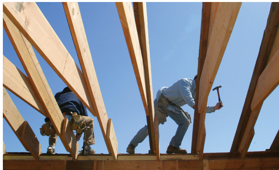
2. ábra: Tartószerkezet építése téglalap keresztmetszetű szerkezeti fából
