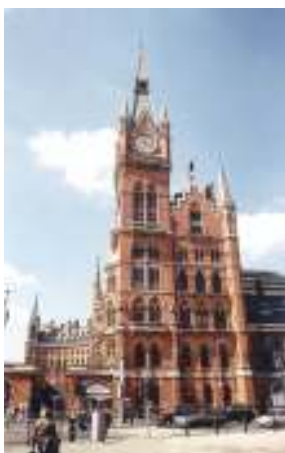
ST. PANCRAS VASÚTÁLLOMÁS London; 1873 - H = 82 m
