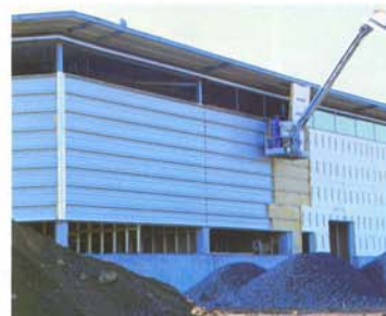
A tűzbiztonság kiemelt szerepet játszik az acélszerkezetek forgalmazásában
