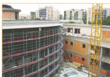
Első emeleti terasztető
