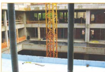
Első emeleti terasztető az üveg bevilágító mellvéd falával
