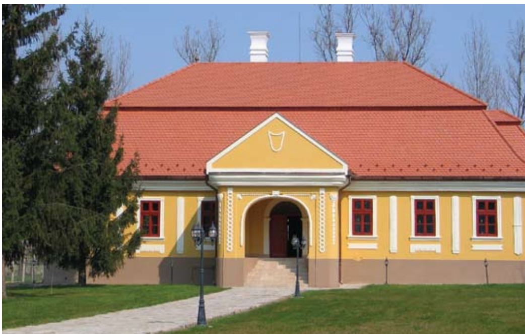
A BAY kúria felújítását a KONCZ-BAU Kft. végezte Beregsurányban
