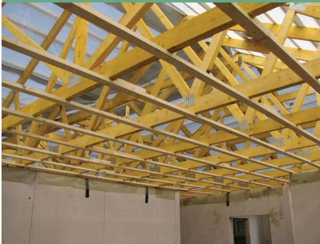
Üzemi előregyártással készült falpanelek és szeglemezes tetőszerkezet
