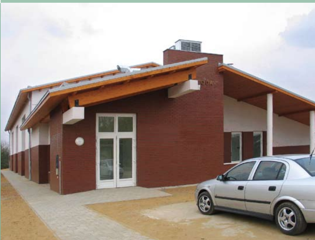
Tanuszoda Nagyvarsányban a KONCZ-BAU Kft. kivitelezésében
