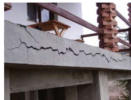
Az aljzatbeton térfogat-növekedésének hatása
