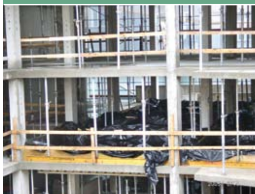
Fóliával bélelt medence próbaterheléshez
