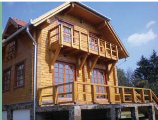
Gerendaházás épület homlokzata
